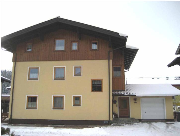
Huber M.: Haus nach Sanierung
